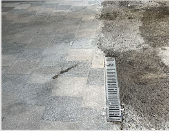
صورة #4: يجب إكمال ترنش المياه لآخر الكراج
