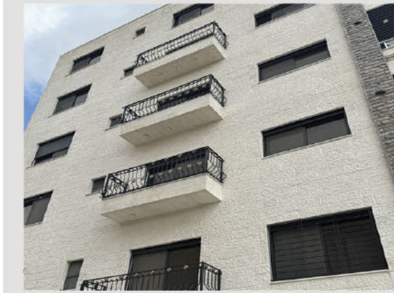
صورة #2: الواجهة الجنوبية بحالة جيدة
