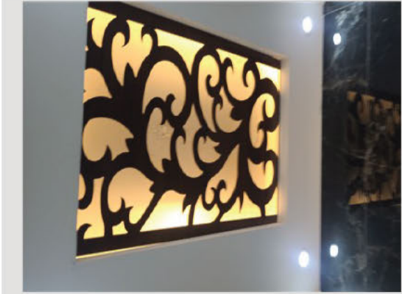
صورة #2: رطوبة بالسقف من تبرك المياه بالسطح
