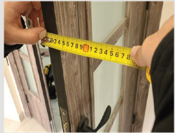
صورة #3: سماكة الحشوة جيدة
