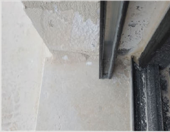
صورة #4: عدم استمرار التامين بزوايا البراطيش
