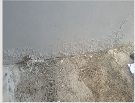
صورة #1: رطوبة بسبب عدم كفاءة العزل المائي
