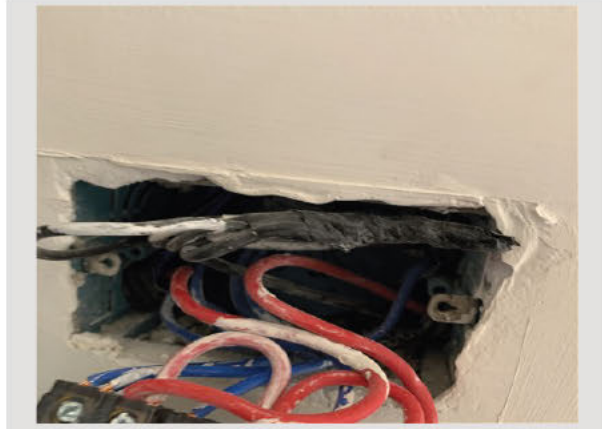
صورة #2: استخدام التاب في التوصيلات - سيء
