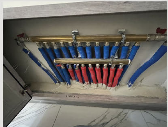
صورة #5: خزانة تزويد المياه جيدة التنفيذ
