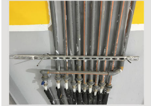
صورة #1: تثبيت انابيب المياه جيد
