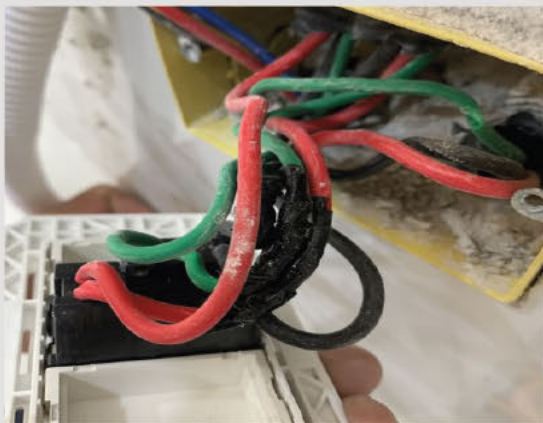
صورة #6: استخدام التاب في التوصيلات - سيء
