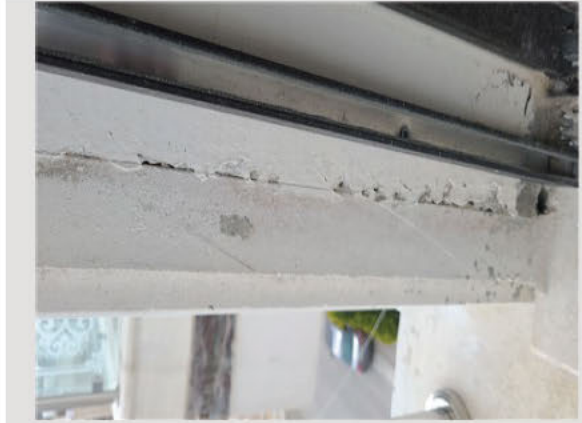
صورة #3: تسرب المياه من بين الحجر و الطوب
