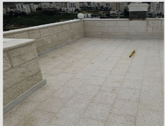
صورة #5: تأكل الروبة و تشقق التمامين
