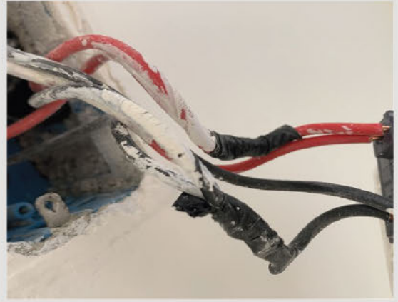
صورة #1: استخدام التاب في التوصيلات - سيء
