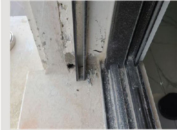
صورة #2: تسرب المياه من سوءالتأمين بالزوايا
