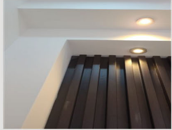
صورة #1: أعمال بديل الخشب مثبتة بشكل جيد
